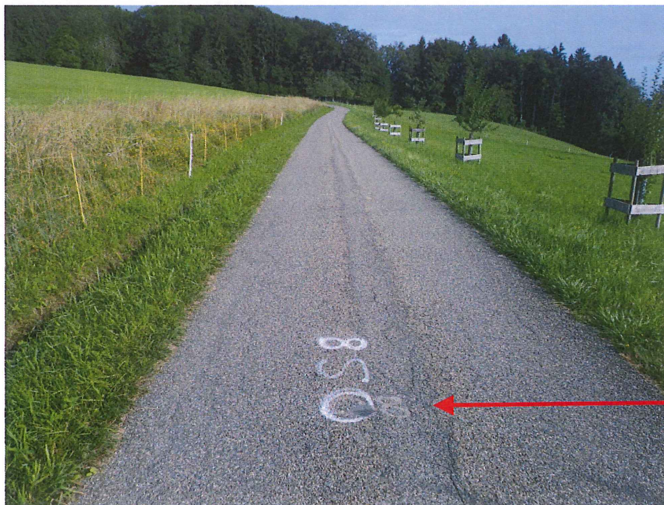
Kernbohrung für Belagsuntersuchung
