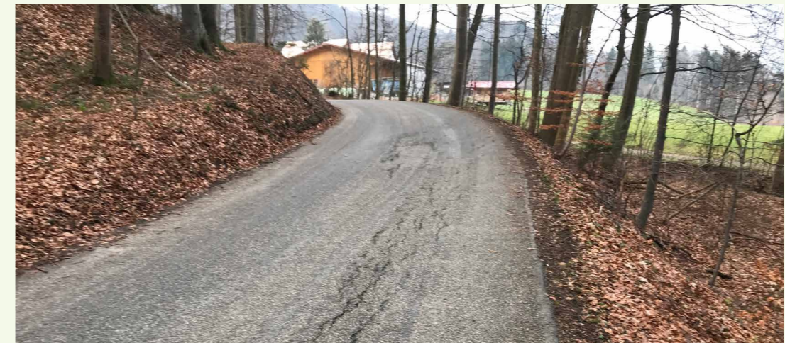
Längsrisse im Bereich der Kurve
