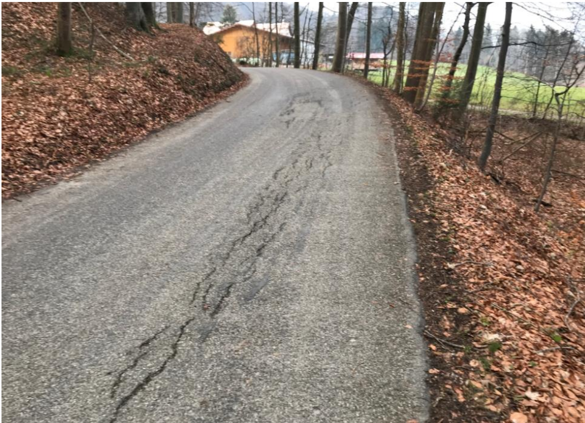
Abbildung 1: Längsrisse im Bereich der Kurve.
