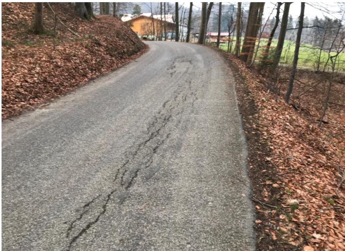
Abbildung 1: Längsrissen im Bereich der Kurve.
