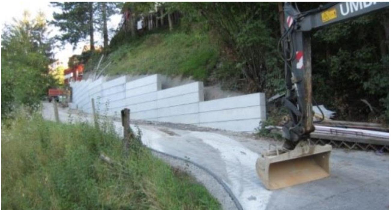
*Bild: Ribbert AG, Vertikal gebohrte Plattenelemente, vor der Hinterfüllung*
