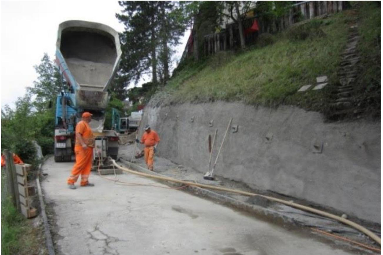
*Bild: Ribbert AG, Vernagelte und mit Spritzbeton gesicherte Baugrube*
